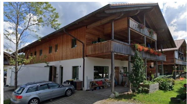
Überdimensionierung - Ausladender Balkon, untypisch im Vergleich zu traditionellen Bauten.
