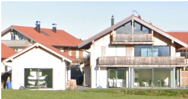
Große Fensterfronten untypisch für das Ortsbild
